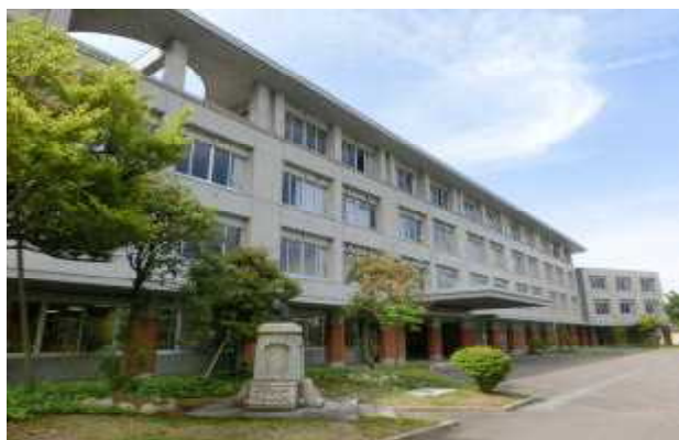
【校舎(平成21年竣工)正面】
