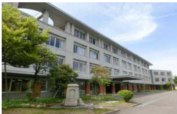
【校舎(平成21年竣工)正面】
